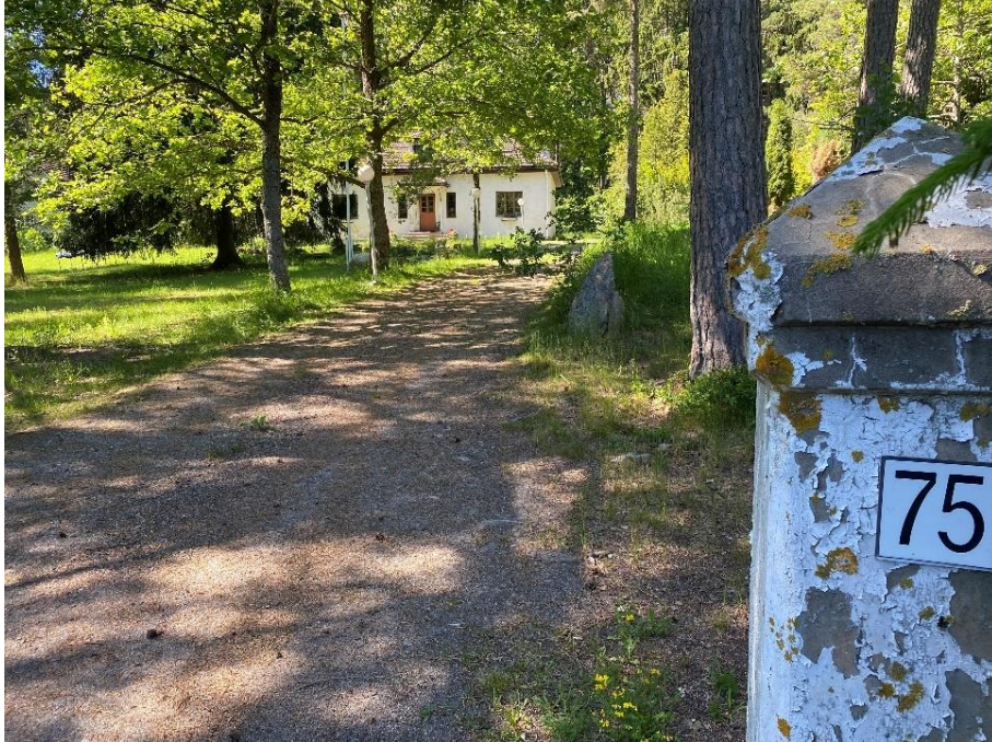
Kuva 29: Entinen Torppalan päärakennuksen talli, joka on nykyisin asuinkäytössä. (FCG, 2022)
