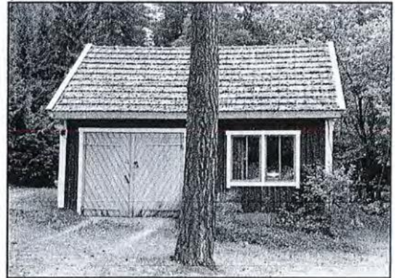
rakennus 3, autotalli / varasto
