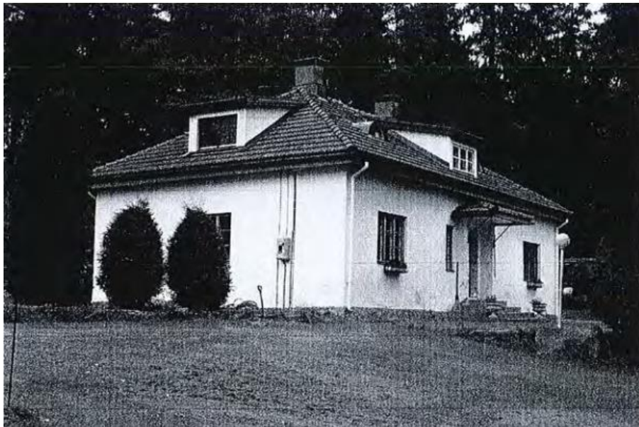
Kuva 30: Rakennus lounaasta (Rakennuskantainventointi).
